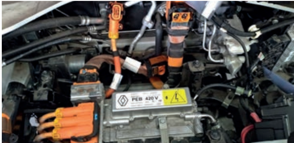
Cabos na cor laranja
